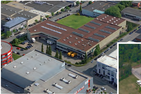
Weichselstraße 9-11, 58256 Ennepetal Logistikzentrum
