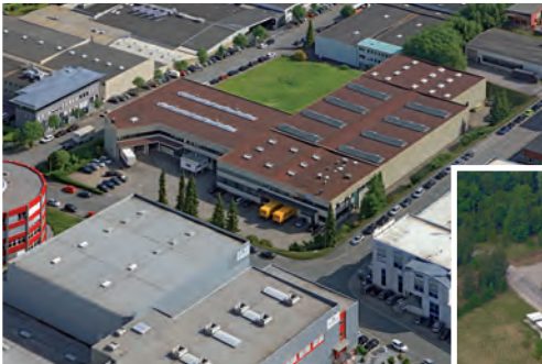
Weichselstraße 9-11, 58256 Ennepetal Logistikzentrum
