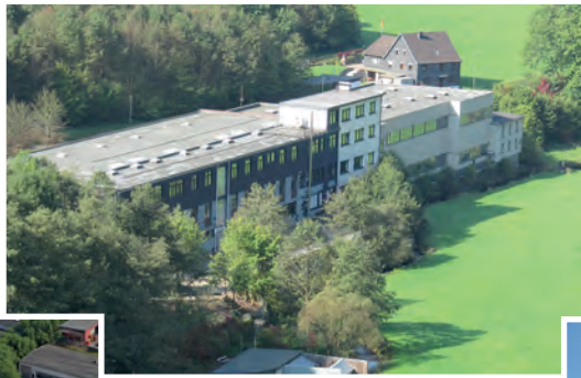
Heilenbecker Straße 191-205, 58256 Ennepetal Hauptverwaltung
