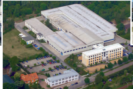
Berliner Straße 50, 04910 Elsterwerda Werk Elsterwerda
