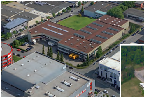
Weichselstraße 9-11, 58256 Ennepetal Logistikzentrum
