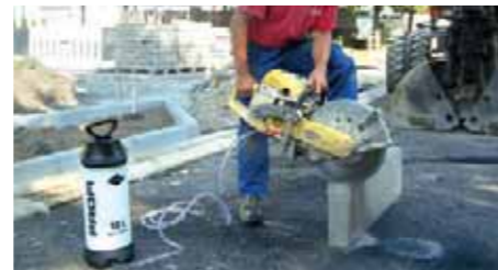
Trennschleifen im Straßenbau
